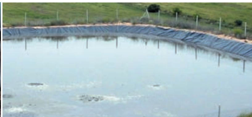
Foto 2. Bassa de purins impermeabilitzada amb una làmina plàstica i amb tancament perimetral. M.R. Teira.
