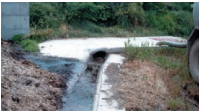
Foto 1. Sistema de recollida de sucs del femer cap a un dipòsit per al líquid d'escolament. M.R. Teira.
