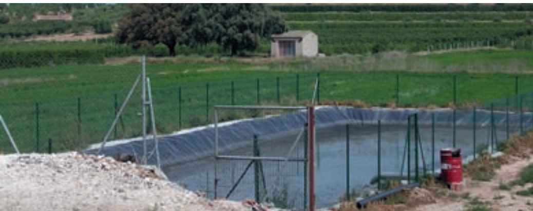
Foto 3. Bassa de purins amb tancament perimetral. M.R. Teira.
