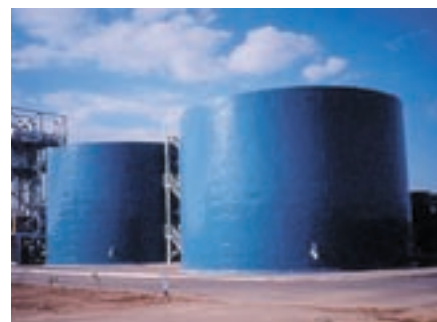
Vista d'una planta de tractament de purins basada en la combinació dels processos de digestió anaeròbia i evaporació, Juneda (les Garrigues). Foto: X. Flotats.
