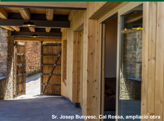
Sr. Josep Bunyesc. Cal Rossa, ampliació obra
