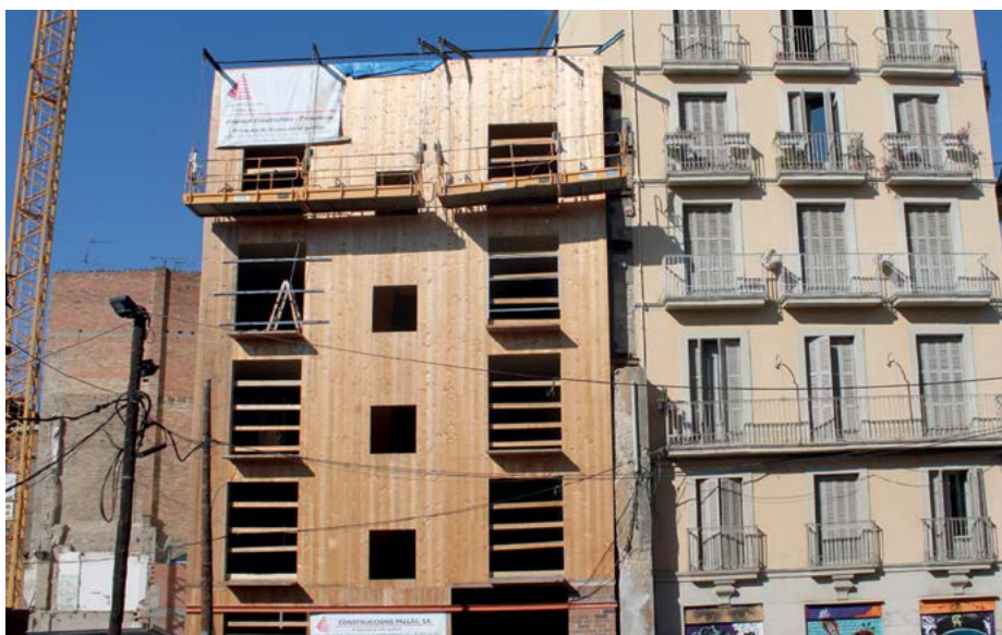
Edificio entre medianeras de CLT. Planta baja más cinco pisos (Lleida). Fotografía: Eduard Correal Mòdol. INCAFUST.
