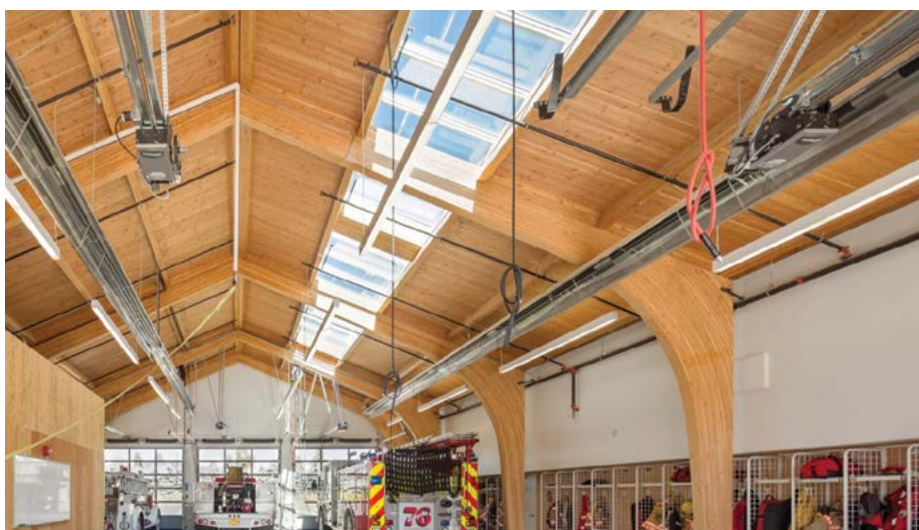
Estación de bomberos 76. Oregón, EE. UU. Hennebery Eddy Architects. Estación de bomberos construida íntegramente en madera. Fotografía: Archdaily.
