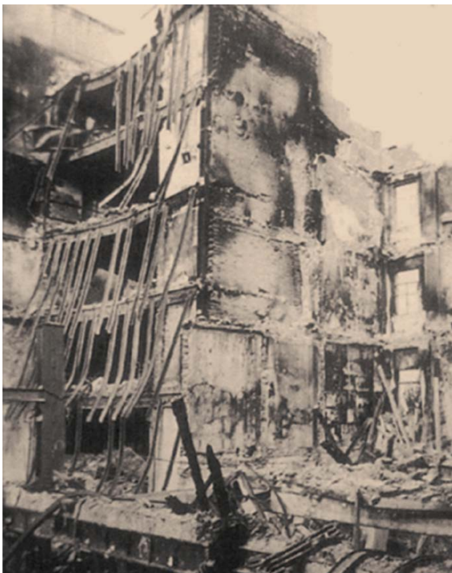
Incendio del edificio Saldos Arias (Madrid, 1987). Parte de la antigua estructura de madera del edificio se había sustituido por perfiles de acero en reformas anteriores. La parte que mantenía la estructura de madera quedó en pie. Víctimas: 10 bomberos. Fuente: Madera y fuego. Cátedra Madera. Universidad de Navarra.
