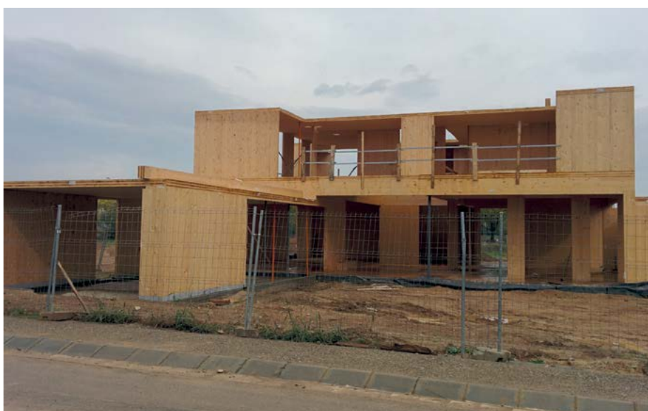
Casa unifamiliar de CLT (Lleida). Fotografía: Eduard Correal Mòdol. INCAFUST.
