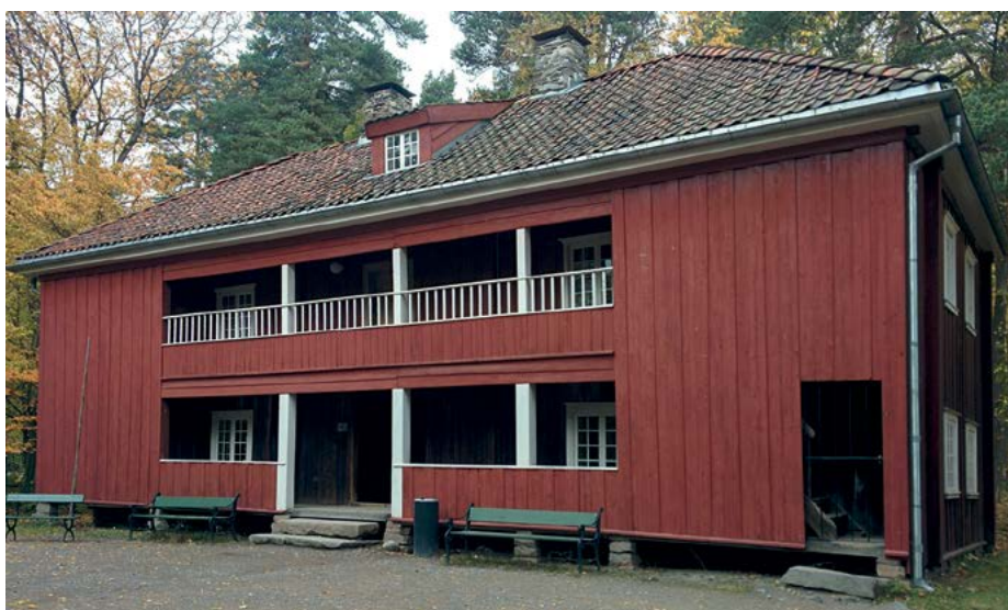
Casa tradicional noruega de entramado ligero (Norsk Folkemuseum, Oslo). Fotografía: Eduard Correal Mòdol. INCAFUST.
