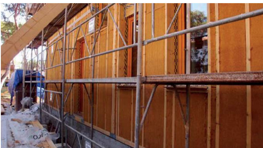
Montaje de la estructura con entramado ligero de madera y del aislamiento térmico de fachada, respectivamente. Fotografías: House Habitat.
