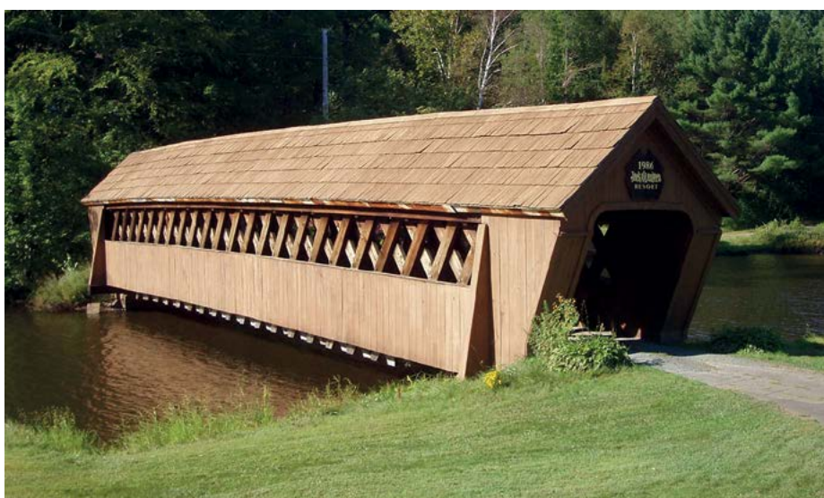
Puente de madera de estructura de entramado pesado (Lincoln, New Hampshire, EE. UU.). Fotografía: Eduard Correal Mòdol. INCAFUST.
