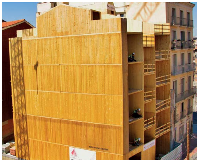
Edificio Cavallers, Lleida. Fotografía: Trass arquitectura.
