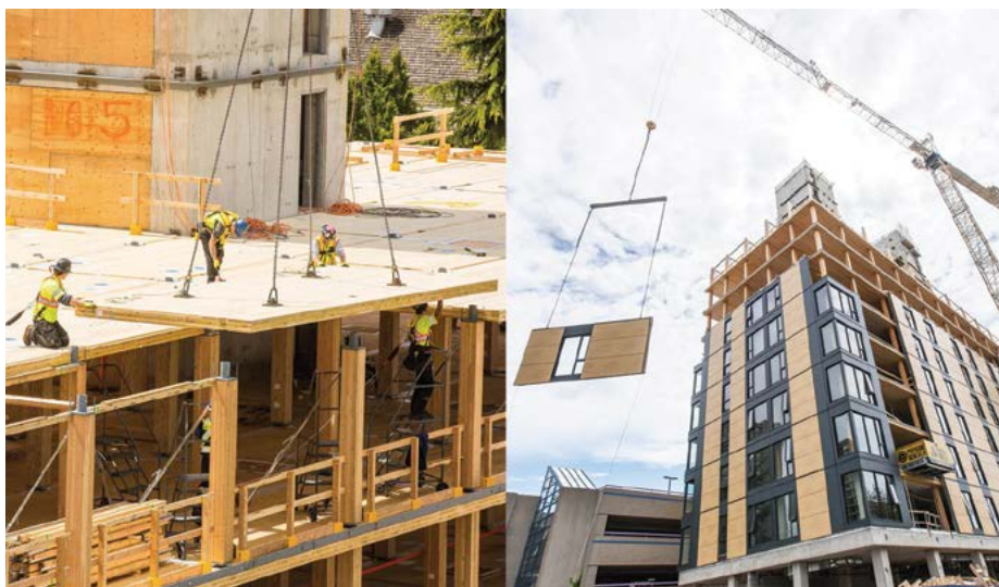
Brock Commons Tallwood House. UBC, campus de Vancouver. Acton Ostry Architects Inc. Actualmente, el edificio más alto del mundo con estructura de madera (18 plantas). Fotografías: maisons-bois.com
