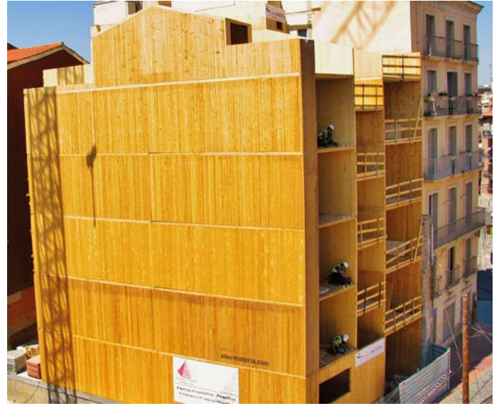
Cavallers Building - Lleida. Photo: Trass arquitectura.
