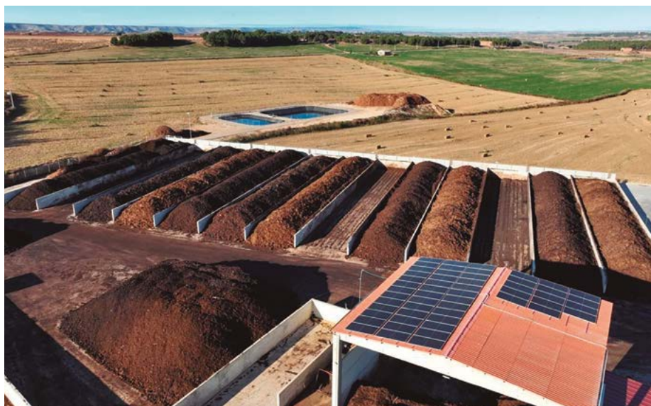
Planta de compostaje. Foto: Alcarràs Bioproductors, SAT.
