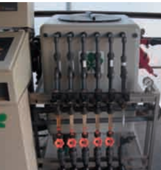
Figura 3. Detall d'un autòmat de reg amb les electrovàlvules i els injectors tipus venturi per a l'elaboració de la solució nutritiva.
