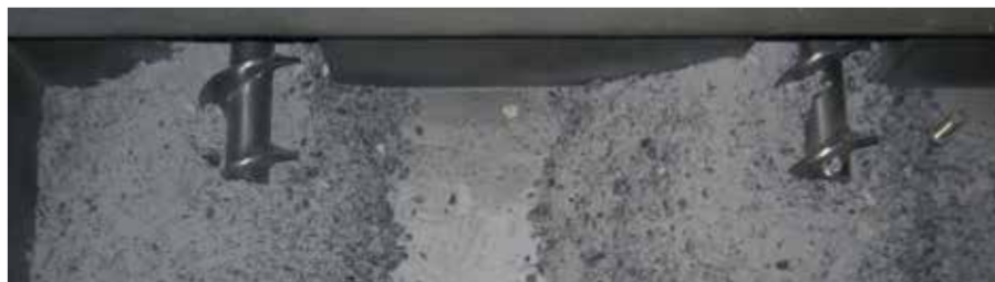
Foto 8. Sistema extracció cendres. Autor: AFIB-CTFC.
