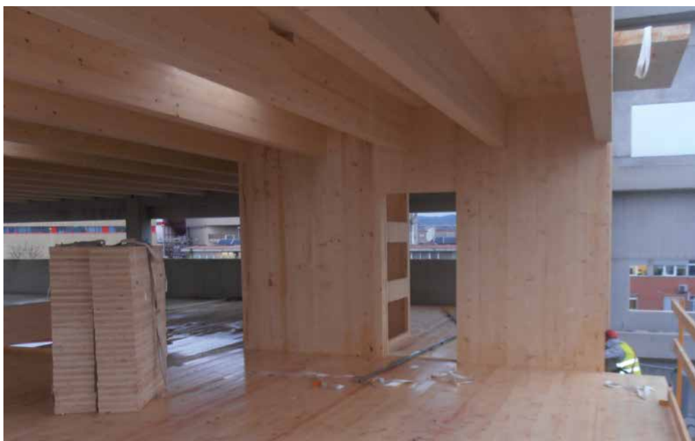
Figura 2: Exemple de construcció amb fusta laminada encolada i amb contralaminat. Autor: E.Correia (INCAFUST).
