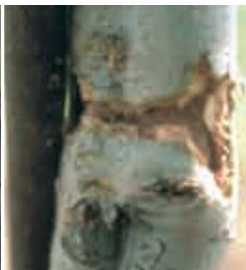
Foto 17. Galeria circular de piral. Foto: B. Celada.
