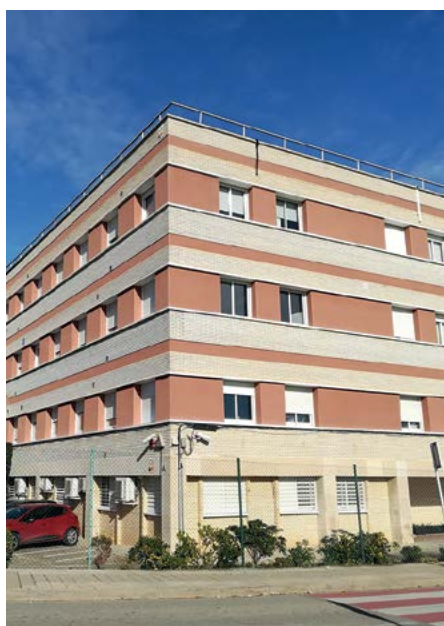
Edificio del LAC. Foto: LAC.
