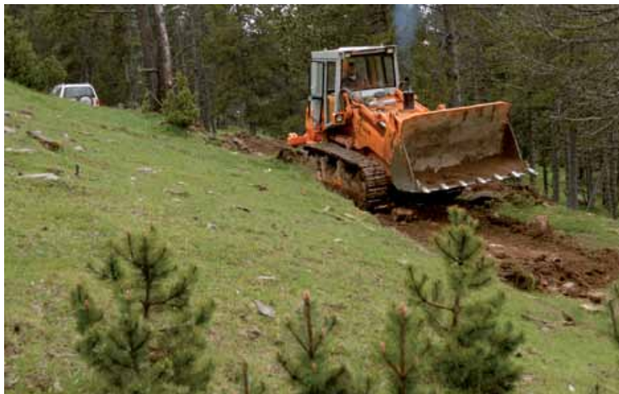
Foto 6: Treballs forestals de recuperació i millora d'hàbitats per a la fauna salvatge en les reserves nacionals de caça. Autor: Richard Martín Vidal.
