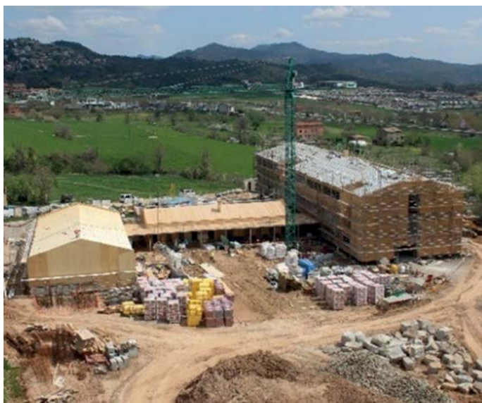
IES Serra Noet - Berga. Foto: Bis Structures.
