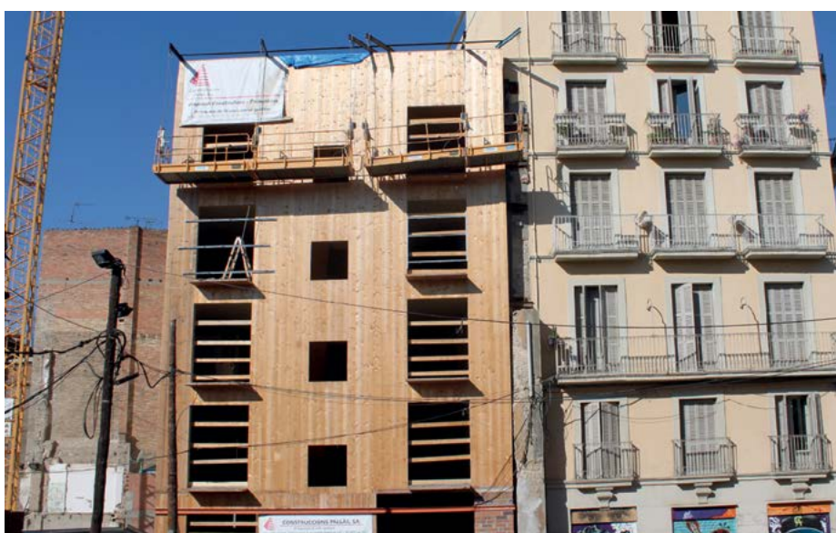
Edifici entre mitgeres de CLT. Planta baixa més cinc pisos (Lleida). Foto: Eduard Correal Mòdol. INCAFUST.
