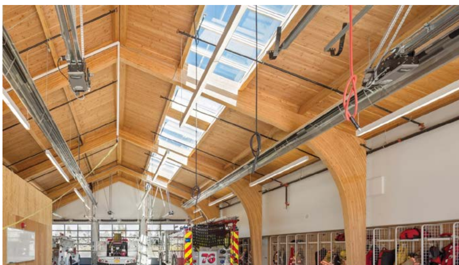
Estació de bombers 76. Oregon, EUA. Hennebery Eddy Architects. Estació de bombers construïda íntegrament en fusta. Foto: Archdaily.
