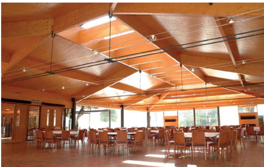
Estructura complexa lliure de pilars bastida amb materials fusters moderns. Foto: Eduard Correal Mòdol. INCAFUST.
