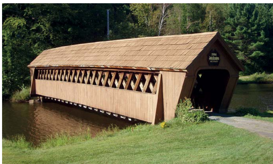
Pont de fusta d'estructura d'entramat pesat (Lincoln, New Hampshire, EUA). Foto: Eduard Correal Mòdol. INCAFUST.
