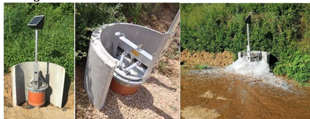
Foto 1. Vàlvula automatitzada per al reg per superfície (Foto: Enginyeria i Gestió del Reg).
