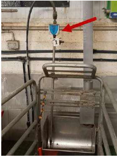
Foto 1. Cabalímetre iPERL de Sensus® instal·lats a un abeurador de truja en la maternitat a la granja Secanell(bonÀrea). (Foto: Eva Mainau).
