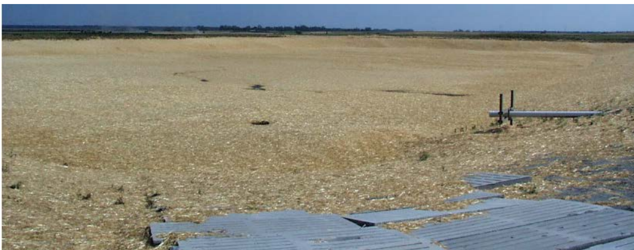
Figura 3. Imatge de bassa amb coberta de palla. Font: Universitat d'Iowa (Review of permeable cover options for manure storage)
