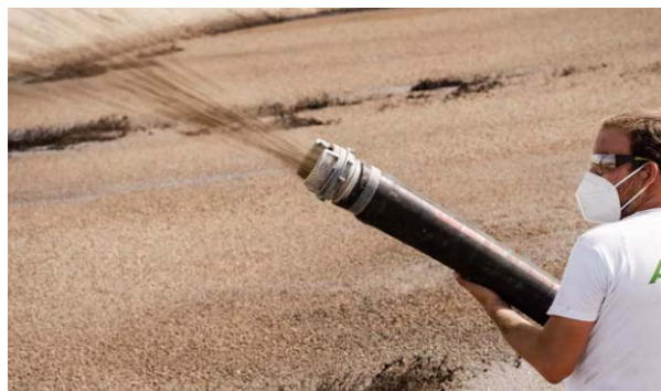
Figura 4. Instal·lació d'argiles expandides mitjançant cisterna (Font: ARVET, SL)
