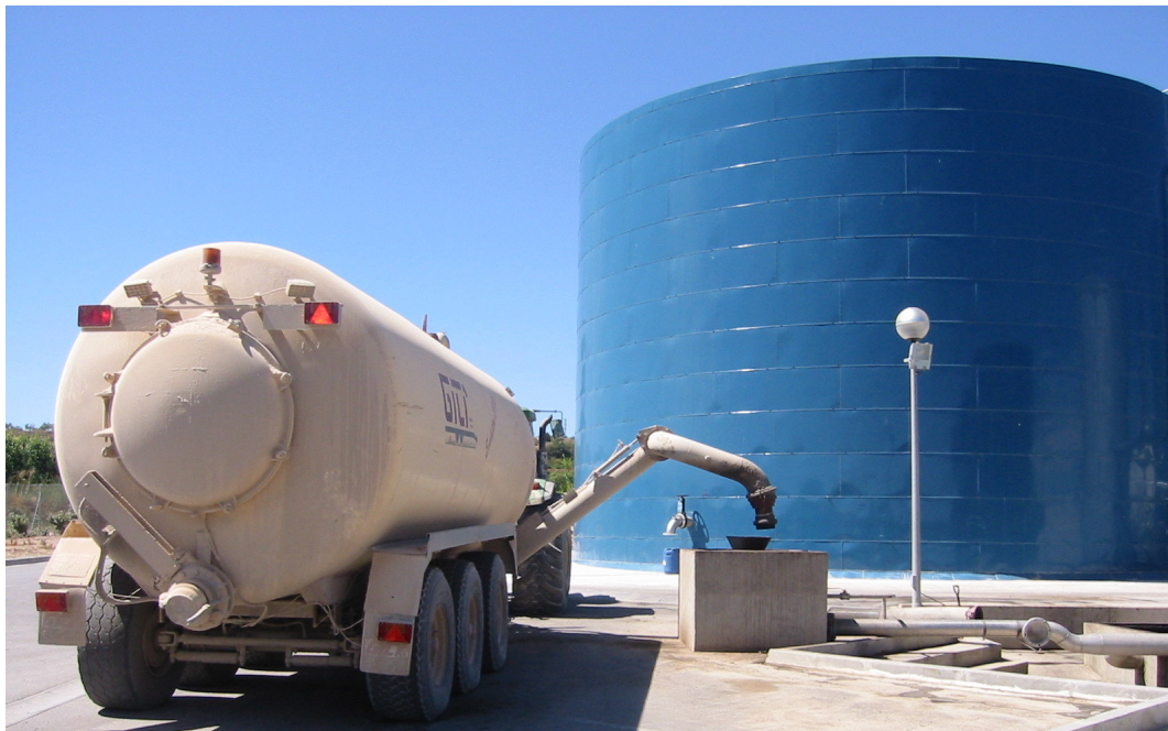
Cuba de transport de purins durant l'operació de descàrrega a la zona d'emmagatzematge de la planta de tractaments
