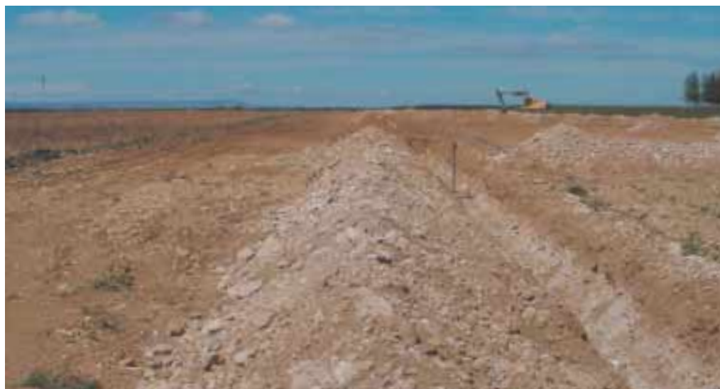
Implantación de un sistema de cobertura total por aspersión sobre un suelo con horizontes cálcicos y petrocálcicos. Estos suelos, poco productivos en condiciones de seco, son bastante productivos con un manejo adecuado del agua de riego y de la fertilidad. Foto: J. M. Villar
