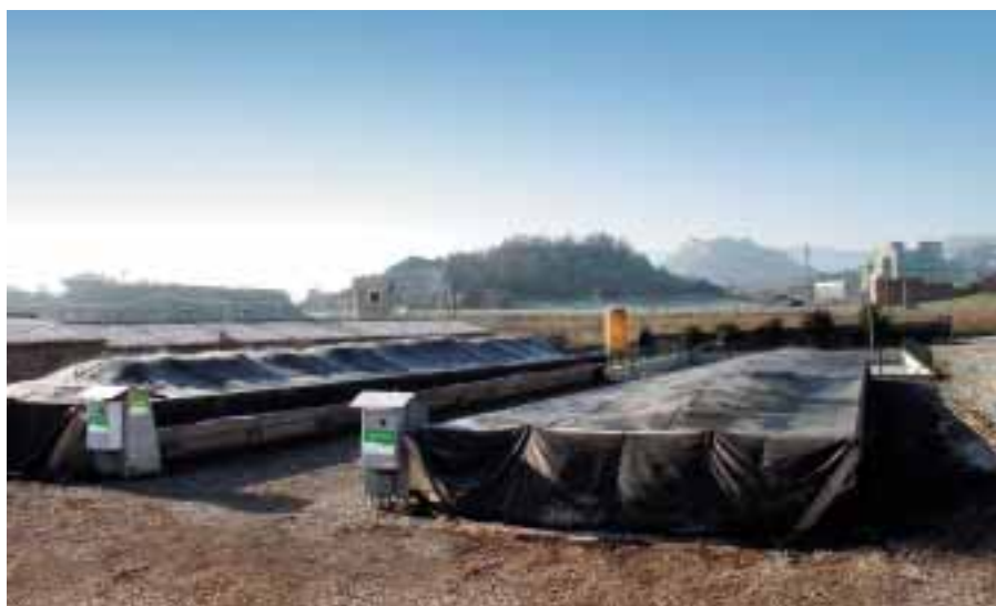
Planta de compostaje. Foto: ECA de l'Empordà.
