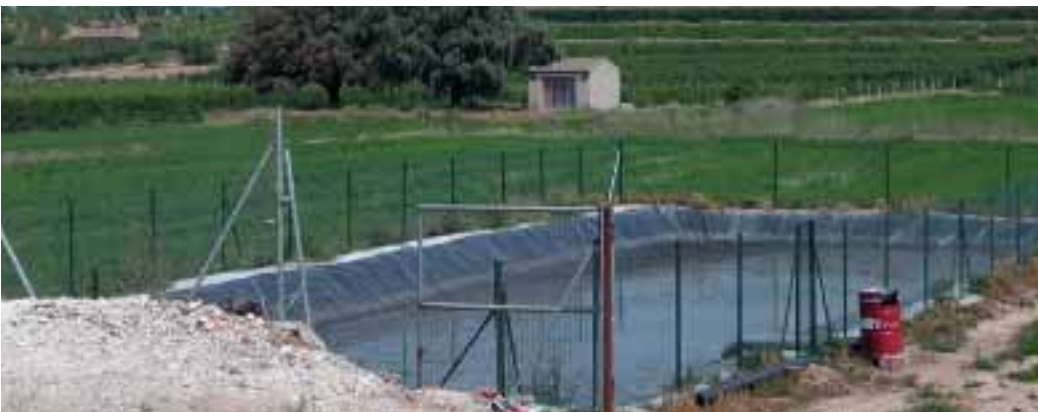
Foto 3. Balsa de purines con cierre perimetral. M.R. Teira.
