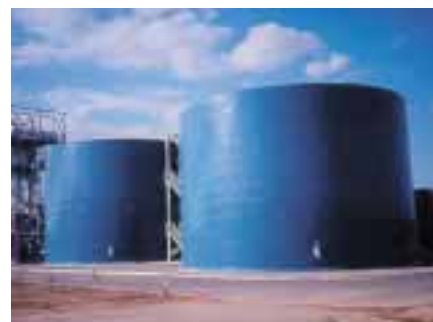
Vista de una planta de tratamiento de purines basada en la combinación de los procesos de digestión anaerobia y evaporación, Juneda (las Garrigues). Foto: X. Flotats.
