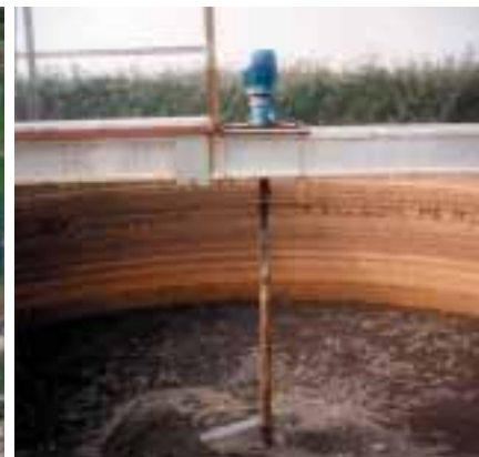
Foto 4. Agitador instalado permanentemente al tanque de purines. A. Magri.
