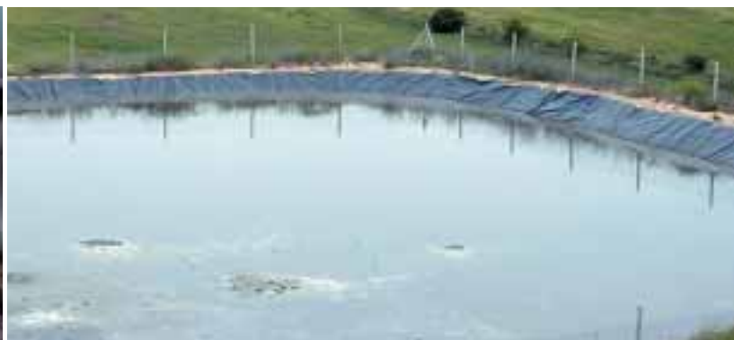
Foto 2. Balsa de purines impermeabilizada con una lámina plástica y cierre perimetral. M.R. Teira.
