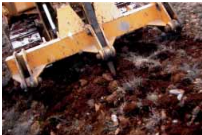
Figura 17. Subsulado del terreno para romper la suela de labor.
