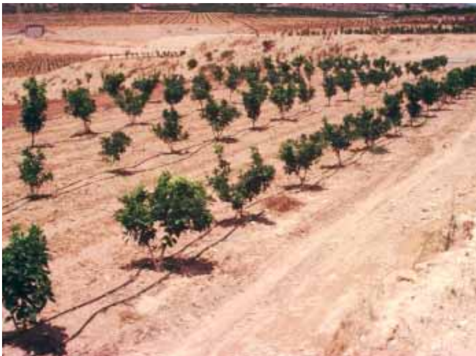
Instalación del sistema de riego. Fotografía: J.R. Castel
