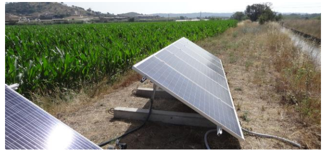
Foto 1. Instal·lació fotovoltaica que impulsava el reg localitzat del blat de moro, amb Vilarnadal al fons i el canal Gros a la dreta. (Foto: Marc Jabardo).
