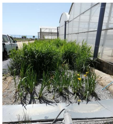
Foto 1. Aiguamoll construït per a l'eliminació de nitrats continguts en lixiviats
