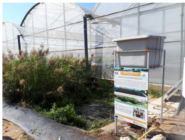
Foto 1. Aiguamoll construït per a l'eliminació de nitrats continguts en llixiviats.
