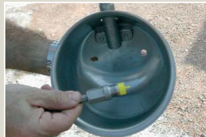
2.- Se desmonta la válvula: algunos bebederos permiten operar sin cortar el paso del agua.
