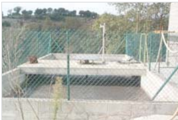
Figura 4.2. Bassa amb agitació i dispositiu per aplicar additius
