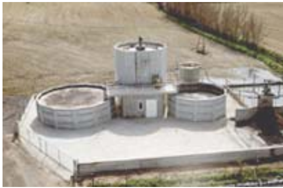
Fig. 4.12. Instal·lació de nitrificació-desnitrificació
