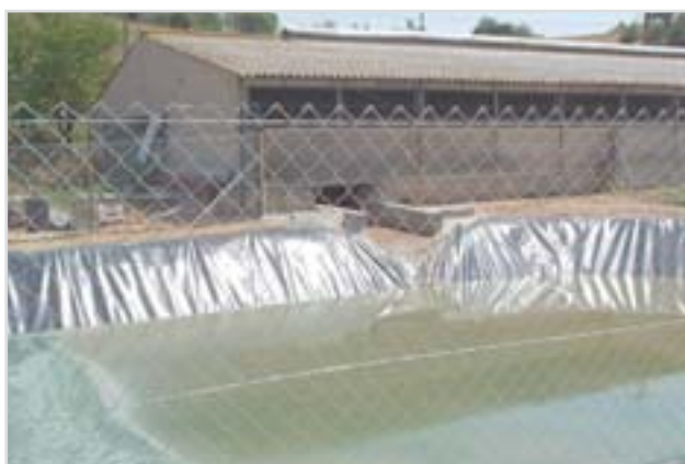
Figura 4.1. Bassa excavada amb làmina de polietilè
