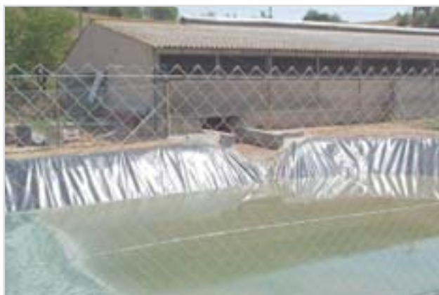
Figura 4.1. Bassa excavada amb làmina de polietilè
