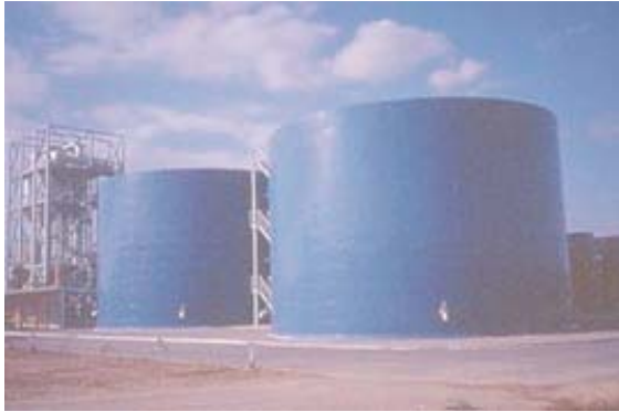
Figura 4.16. Planta centralitzada de digestió anaeròbia
