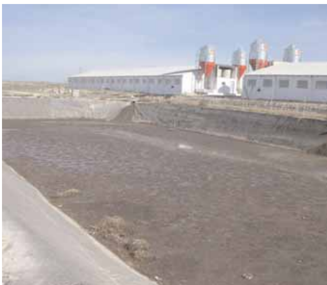
Foto 7: Balsa de almacenamiento de purín porcino.
