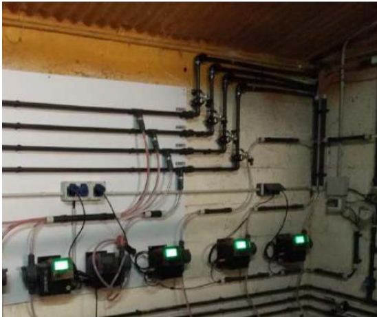
Foto 1. Fotòmetre per mesurar els nivells de nitrats i nitrats (Foto: Marçal Verdú, BonArea Agrupa).
