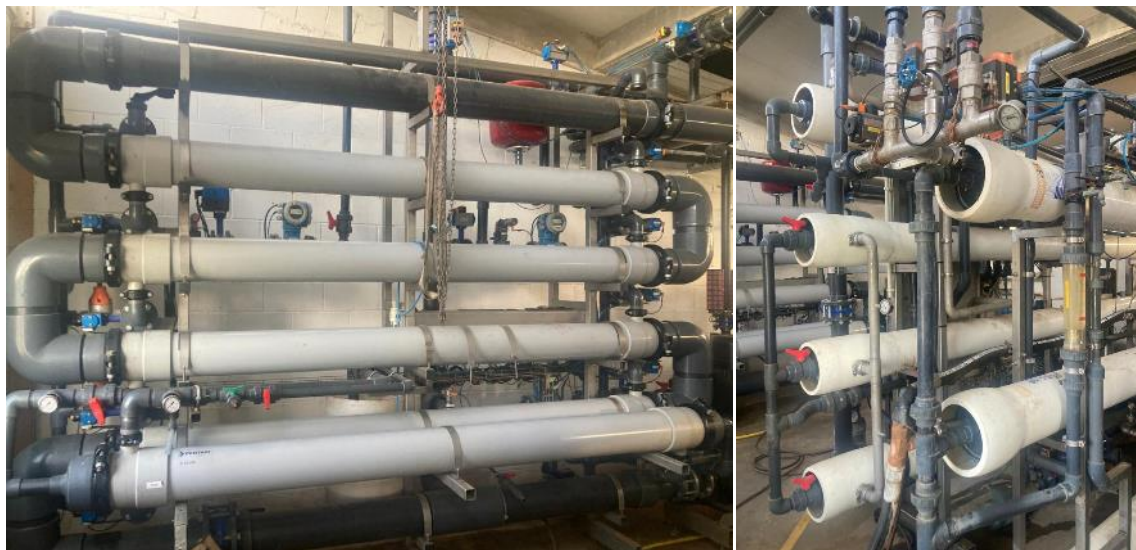
Figura 3.6.2. Sistemes de separació per membranes de ultrafiltració (esquerra) i de òsmosi inversa (dreta).
