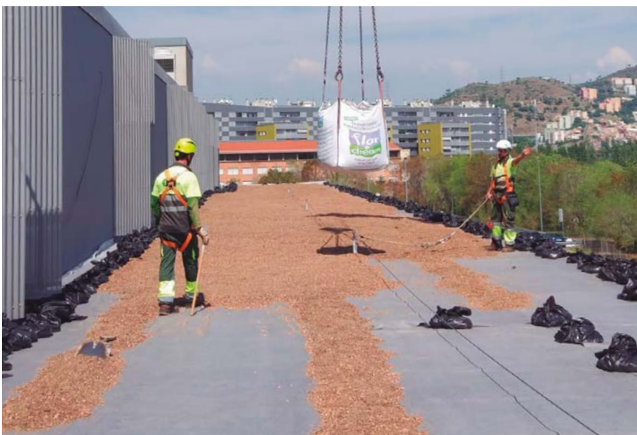
Treballadors de TEB Verd durant el procés de construcció de la coberta verda. Foto: Dpt. de Comunicació TEB.
